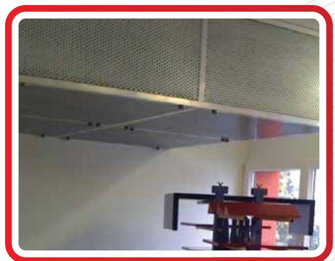
Zulufthaube mit Deckenfilter, für eine staub- und zugfreie beheizte Querlüftung in jedem Lackierraum (auch nachrüstbar)
