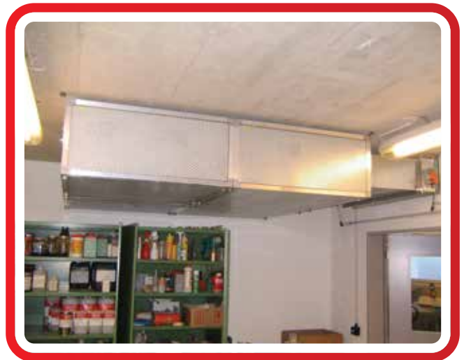
Beispiel Zulufthaube mit Deckenfilter für eine staubfreie Querlüftung
