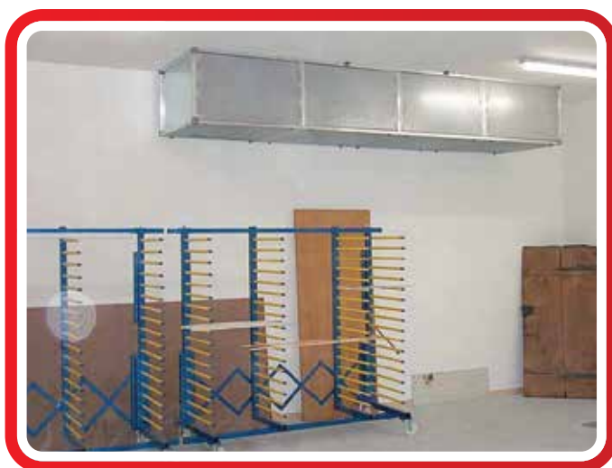
Zulufthaube mit Deckenfilter, für eine staub- und zugfreie beheizte Querlüftung in jedem Lackierraum (auch nachrüstbar)
