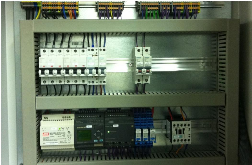
Blick in den Steuerschrank mit Siemens SPS mit Service Display, an welchem alle Meldungen ablesbar sind
