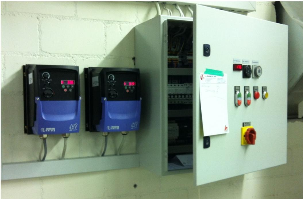
Steuerschrank mit Bedientaster, Betriebs- und Störleuchte, seitlich zwei IP 66 Ventilator Frequenzumformer zur stufenlosen Leistungsregulierung für Über- oder Unterdruck je nach Anforderung, sowie mit Energiesparfunktion
